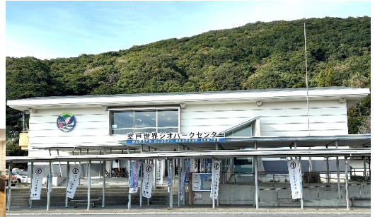
室戸世界ジオパークセンターの外観
